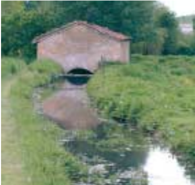
Vue depuis l'aval.
